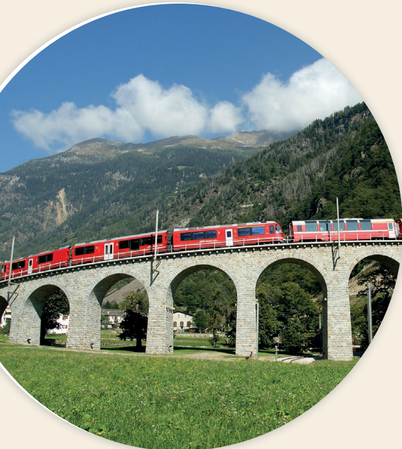
Das Kreisviadukt von Brusio im Schweizer Kanton Graubünden ist das Wahrzeichen der Berninalinie.
